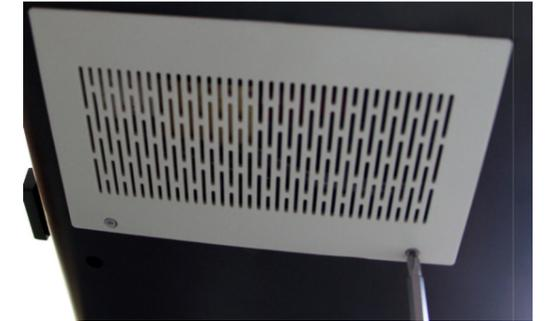
C. Usar un destornillador Philips para quitar los tornillos del marco del filtro.
